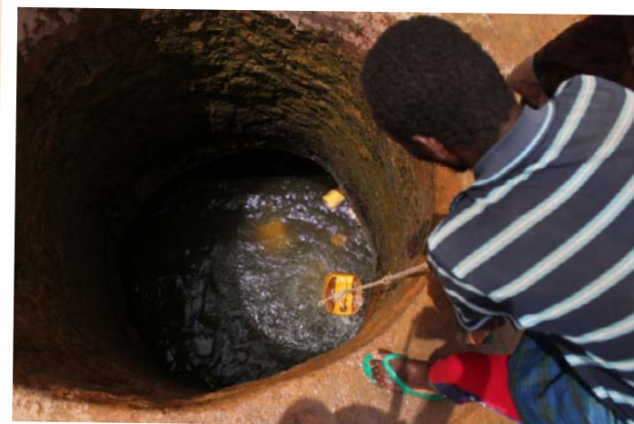
OPRAVENÁ STUDNA (PAVEL ČAHA)
